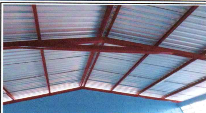
Foto 2: Estructura de soporte de metal lijada y pintada
