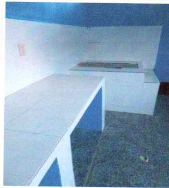
Foto 4: Plancha y pila sustituidas
