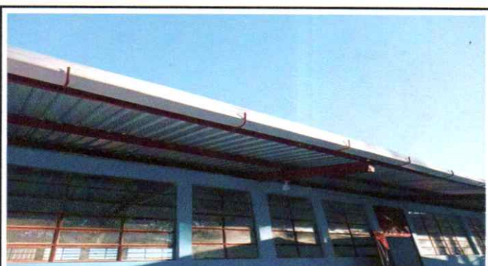
Foto 4: Canales pvc sustituidos
