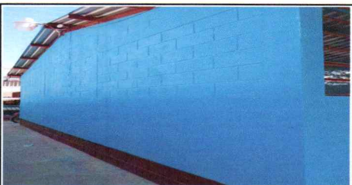
Foto 5: Aplicación de pintura concluida
