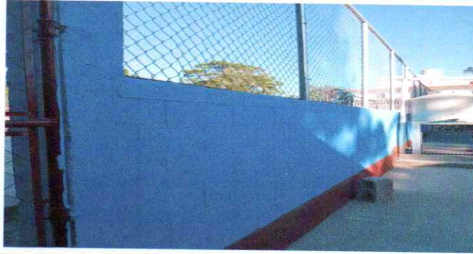
Foto 1: Malla Sustituida
