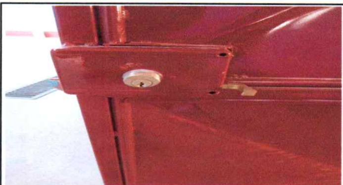
Foto 3: Chapa sustituida
