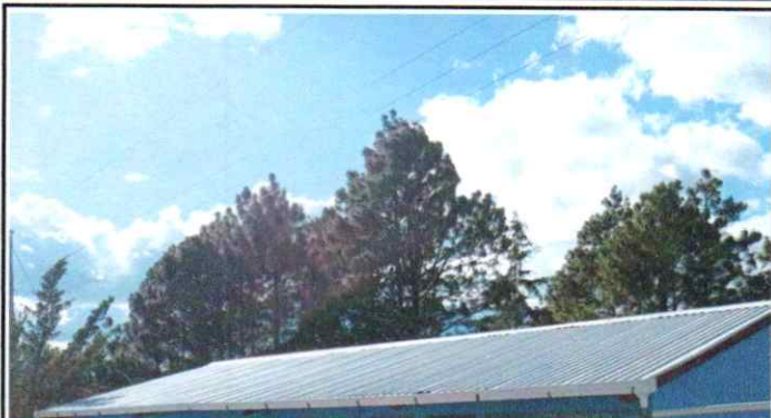
Foto1: Cubierta de lámina finalizada
